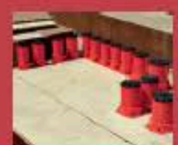
Огнезащита проходок монолитных конструкций
