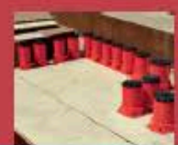
Огнезащита проходок монолитных конструкций
