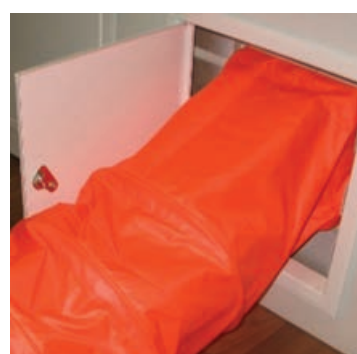
Удаление через шахту ДУ
