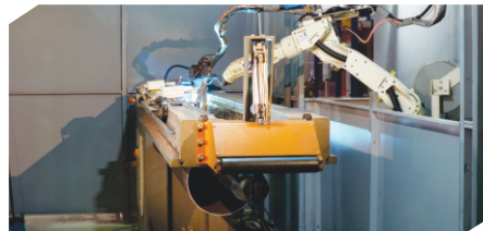
участок сборки и роботизированной сварки
